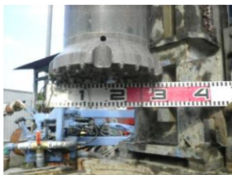
井戸掘さくマシン 掘さく孔径300mm
